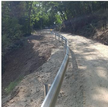
Il progetto riguarda il completamento delle opere di messa in sicurezza di una frana che comportano la sistemazione della scarpata, la posa di una barriera stradale in acciaio corten e la manutenzione di gran parte del tratto stradale con opere di drenaggio delle acque superficiali e posa di compattato.
