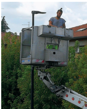
Sostituzione della vecchia illuminazione pubblica con lampade a Led
