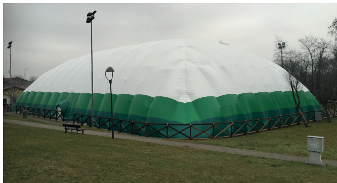
La copertura della pista al parco Lavezza
