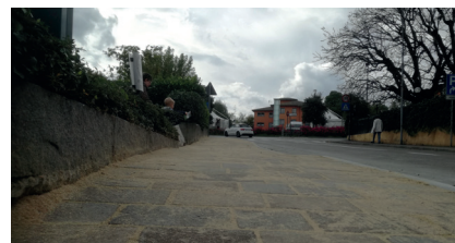
La riqualificazione dei marciapiedi su via Vittorio Emanuele II
