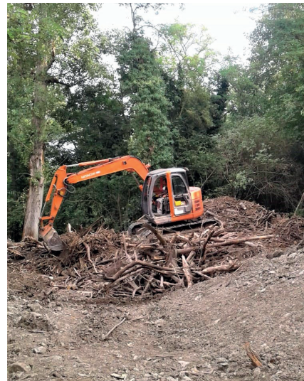
Lavori di messa in sicurezza del Rio Lavezza
