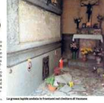
La grossa lapide caduta in frantoni nel cimitero di Vezzano
