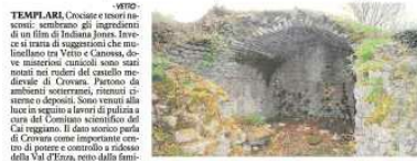
TRA STORIA E LEGGENDA Uno dei cantieri scoperti a Crovara
