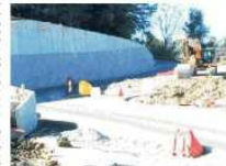
Lavori, aggiustati a lavoro, sono stati rimossi per la strada di Parma
