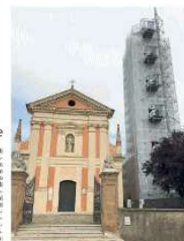
Il campanile di Barco in fase di restauro
