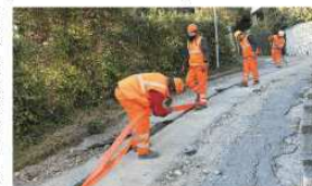
TUTTO PRONTO I lavori partiranno entro l'autunno e, nelle previsioni, dovranno un anno. Per il collegamento di 16 scuole in tutto il territorio comunale.
