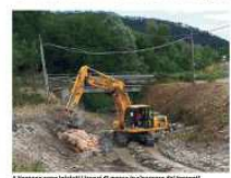
A Vezzano sono iniziati i lavori di messa in sicurezza del torrente
