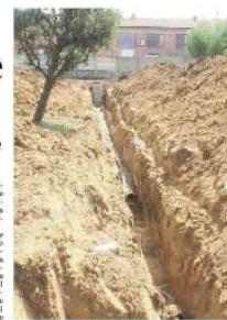
Il cantiere per la fognatura nella zona di via Piave a Monteccholo
