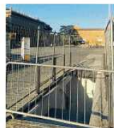
A sinistra la rampa del Park Vittoria. In alto: l'uscita d'emergenza
