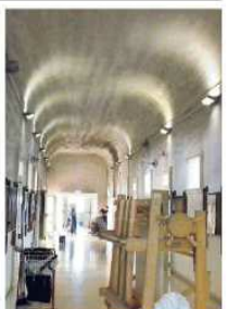
Il corridoio bocciato e ora pronto dagli operai
