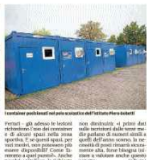
Container prefabbricati nel polo scolastico dell'istituto Gobetti
