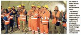
Il giorno "Terremoto", ieri martedì 11 aprile, è stato un giorno importante per Casina e per il territorio reggiano. È stato abbattuto l'ultimo diaframma della seconda galleria del tunnel Bocco-Canala.
