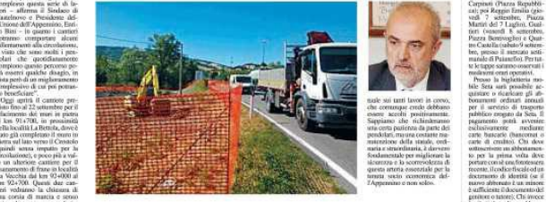
Lavori urgenti per la provinciale 91 a Collagna, la Regione si muova»
