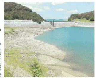
Il impianto idroelettrico del Lagastrello. La bonifica propone di usare gli invasi Enel per l'irrigazione dei campi.
