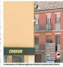
Le telecamere di videosorveglianza installate in piazza della Libertà.
