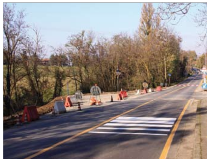
Tratto della SP25 dove sarà realizzata la rotatoria
