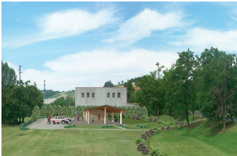
Centro Sovracomunale Anti-Incendio Boschivo sito a Vezzano s/C
