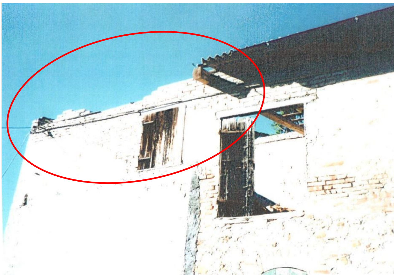
Figura 7 Particolare della copertura parzialmente crollata a causa della tromba d'aria
