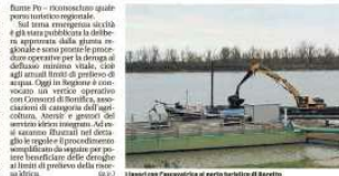
Lavori in fase di completamento al porto turistico di Boretto
