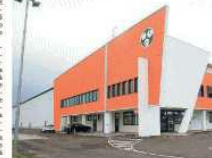
Il nuovo stabilimento da 37 mila metri quadrati della Metall Steel, che ha investito 15 milioni e occupa 10 addetti
