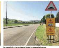
La segreteria che serve dai lavori la corsa a Salvarano
