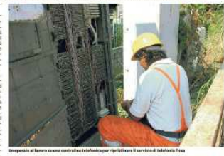
Un operaio al lavoro su una condotta telefonica per ripristinare il servizio di telefonia fissa
