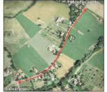
Il nuovo tratto della pista ciclopedonale tra Montecavolo e Salvarano.
